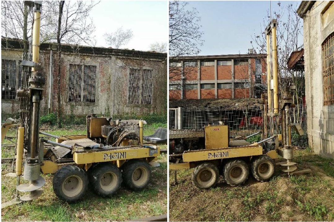
Figura 5.2 – Esecuzione delle prove SCPT3 e SCPT4
