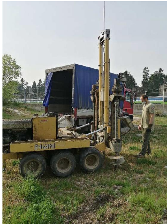
Figura 5.3 – Esecuzione della prova SCPT5
