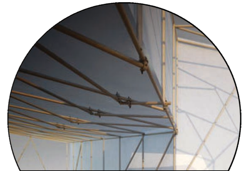
rivestimento in telo pvc
