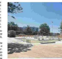
PARCHI «PETRACHI» Sono iniziati i lavori per la riqualificazione dell'area
