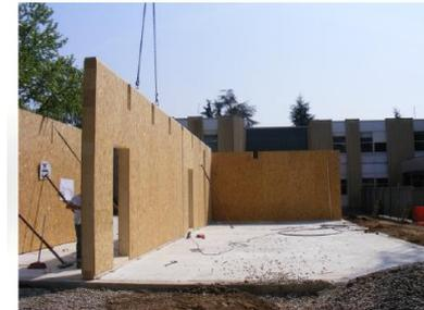
TAMPONAMENTI ESTERNI PREASSEMBLATI DEL TIPO «A TELAIO», CON MONTANTI VERTICALI IN LEGNO LAMELLARE, ISOLANTE INTERPOSTO E CHIUSURA SULLE FACCE A BASE DI LEGNO DI CONIFERA
