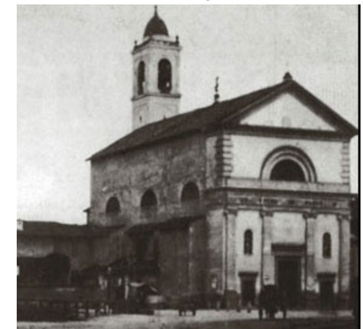
Fig. 9: La chiesa di S. Pietro in Sala prima della demolizione nel XX secolo.
