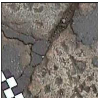
Figura 13: Asportazione di sigillante dai giunti
