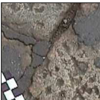
Figura 13: Asportazione di sigillante dai giunti
