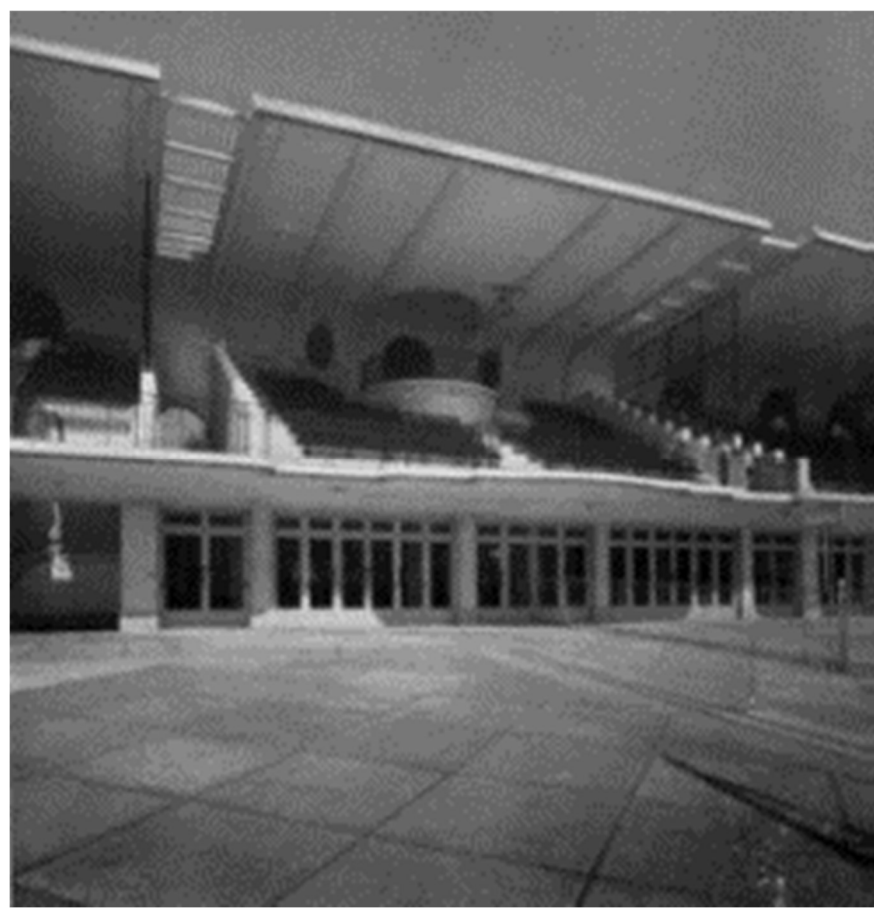
Figura 1-7 La tribuna del Trotto (1926) demolita all'inizio degli anni '70 Nel 1972 la Tribuna del Trotto, forse la migliore delle architetture ippiche del Vietti Violi, con una copertura a sbalzo ardita per l'epoca (1920) viene sostituita con una nuova tribuna, più funzionale, ma priva di alcuna rilevanza architettonica.
