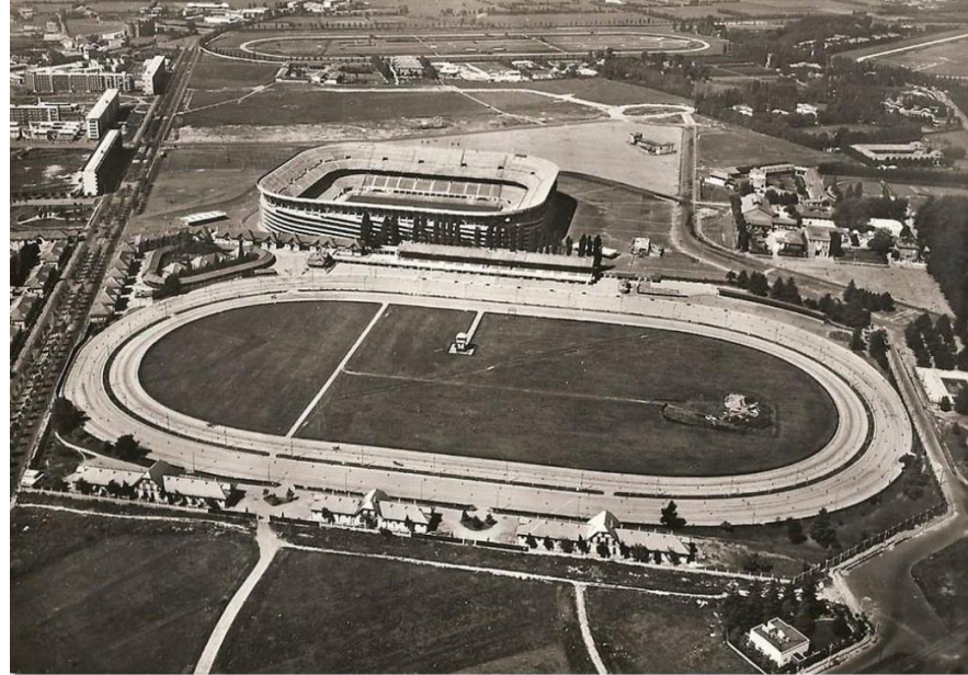
Lo stato dell'area sportiva dopo la costruzione del secondo anello dello stadio e il completamento delle scuderie/fienili sul lato est del Trotter (in primo piano)
